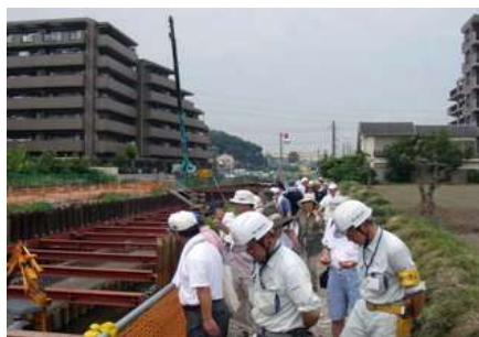
(写真2) 越戸川再生護岸工事見学会
